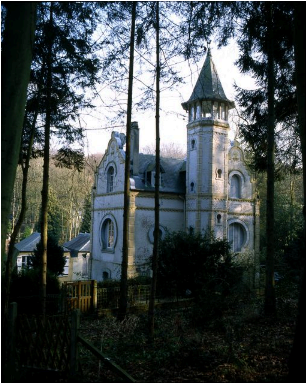
Vue de trois-quarts sur les élévations latérale droite et postérieure.
