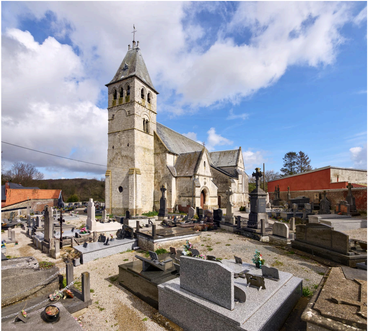
Vue de l'église entourée du cimetière depuis le sud.
