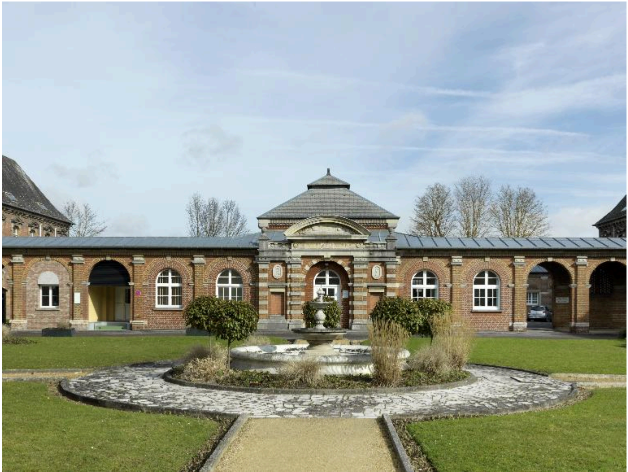
L'ancien pensionnat. Ancien pavillon des services (cuisine et bains).
