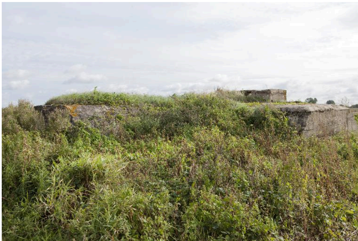
Vue postérieure, vers le sud-est
