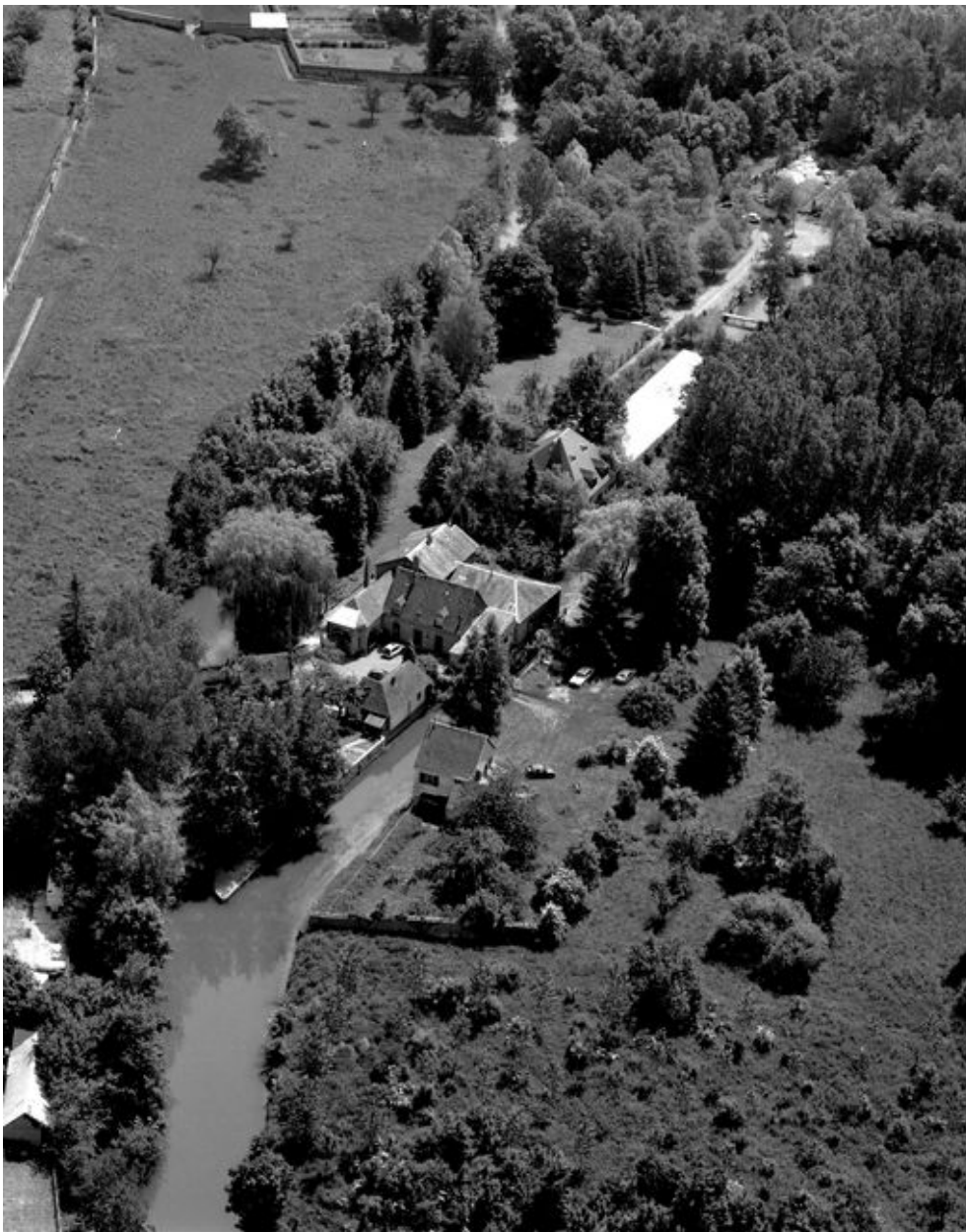
Vue aérienne de l'usine en 1994.
