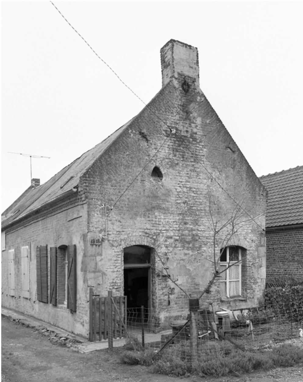
Vue d'ensemble nord-est.
