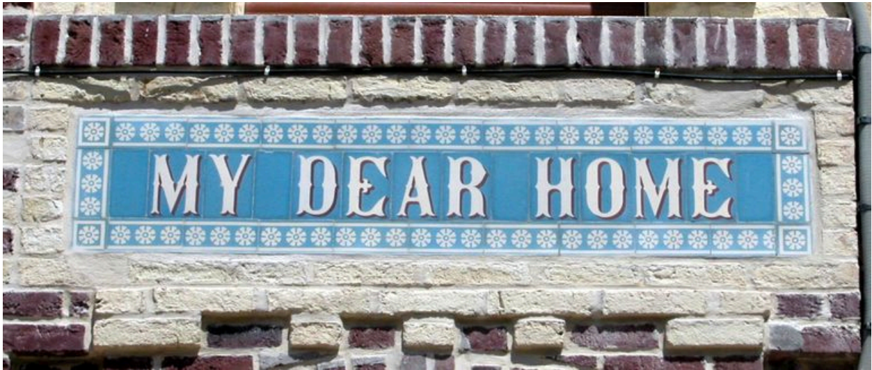
Détail des carreaux de céramique portant appellation.
