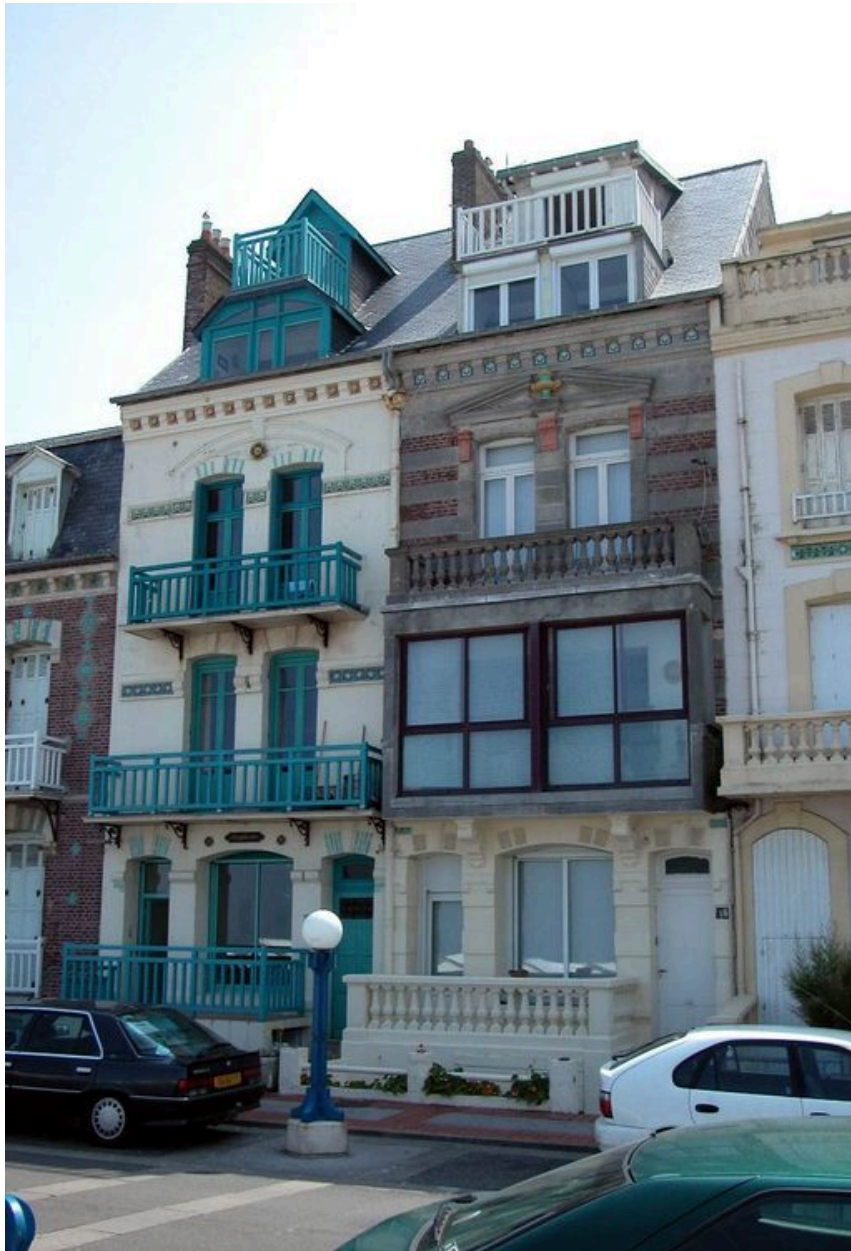
Vue d'ensemble depuis l'esplanade.
