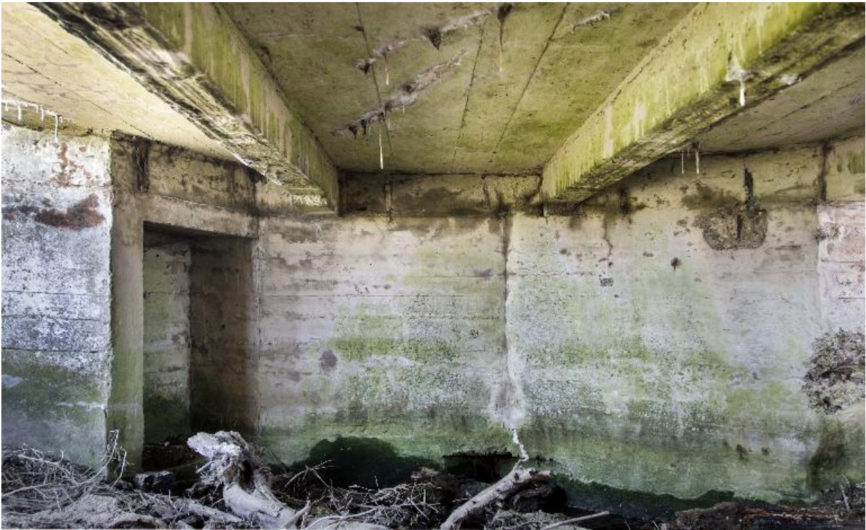
Vue intérieure, paroi ouest de la chambre de tir.
