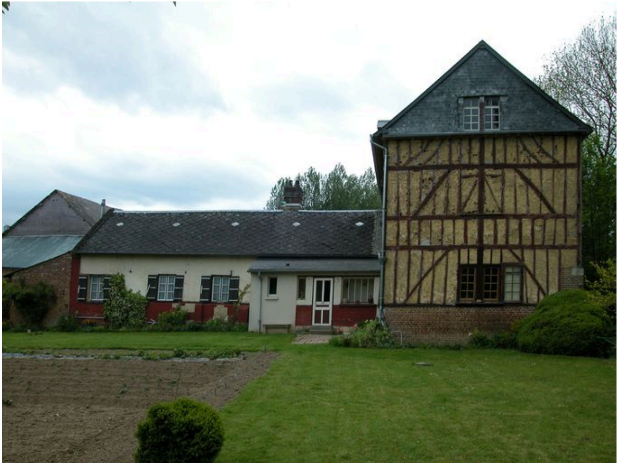
Façade sur jardin du pignon du moulin et du logement de meunier.
