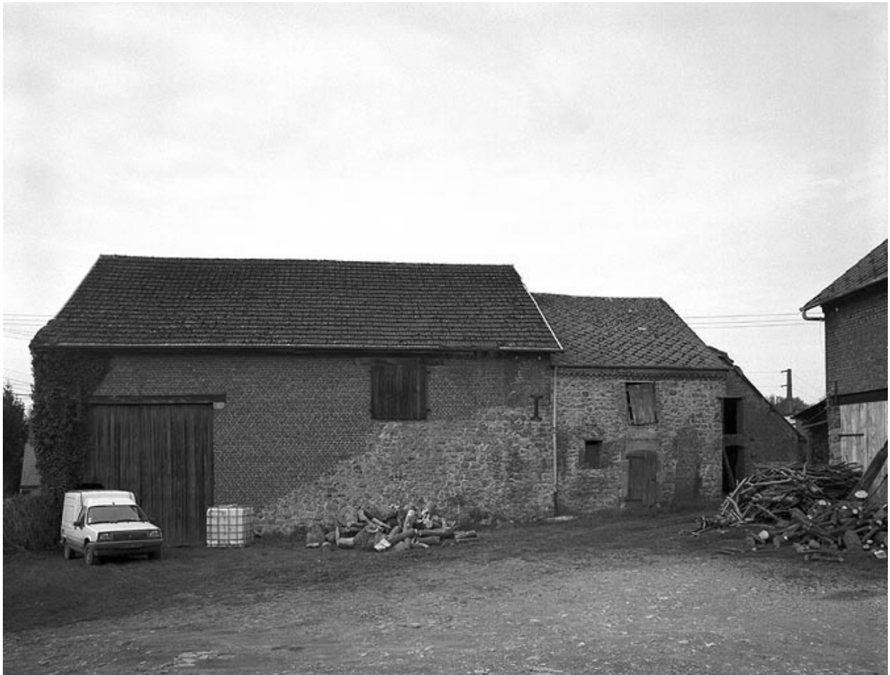
Vue des bâtiments d'exploitation situés à l'ouest.
