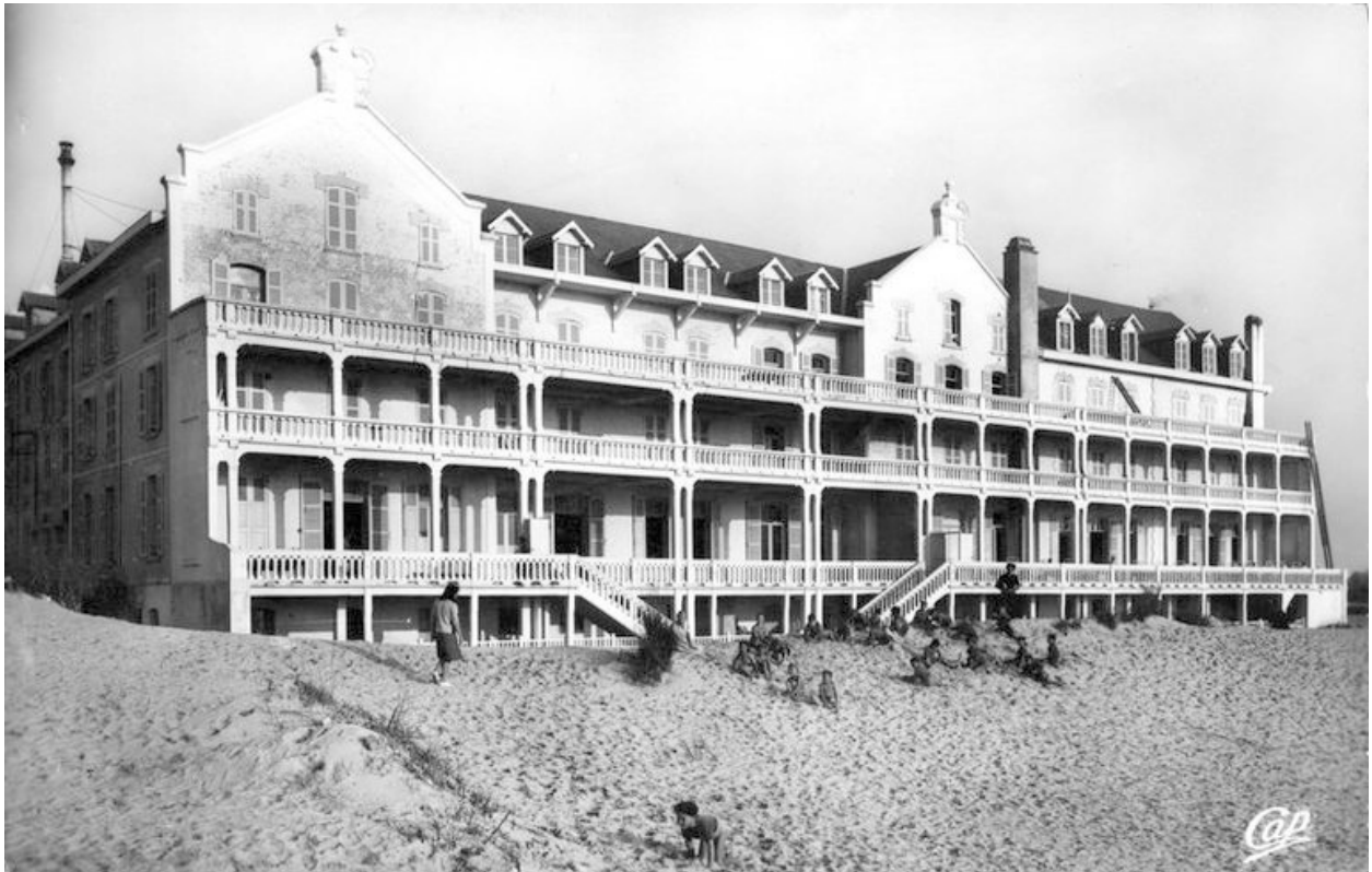
Elévation antérieure après le remplacement des galeries de cure en charpente par des galeries en béton armé, vue générale prise de trois-quarts gauche. Carte postale, vers 1925 (coll. part.).
