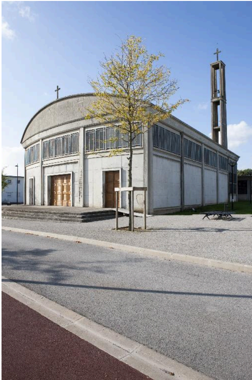
Vue de trois quarts de l'élévation antérieure et du flanc droit.
