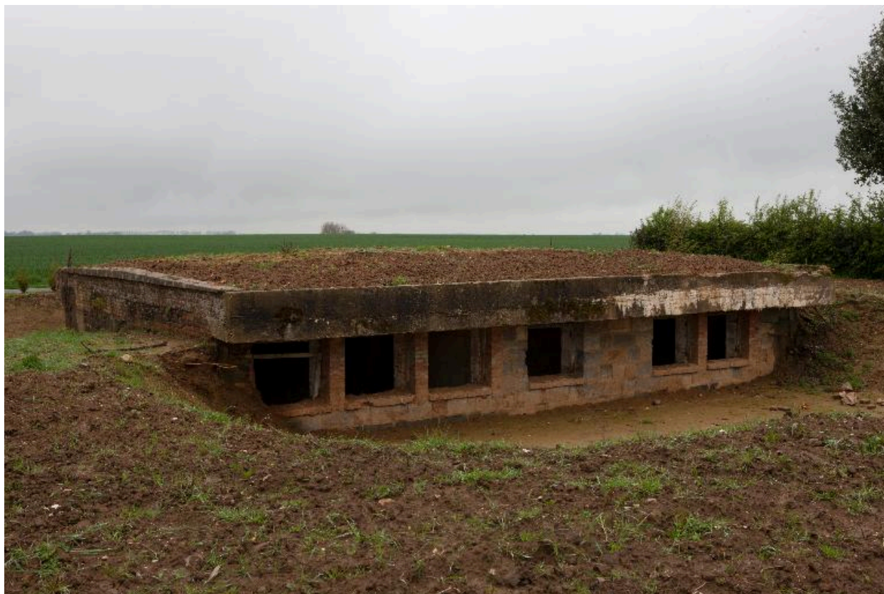
Abri casernement : vue antérieure.
