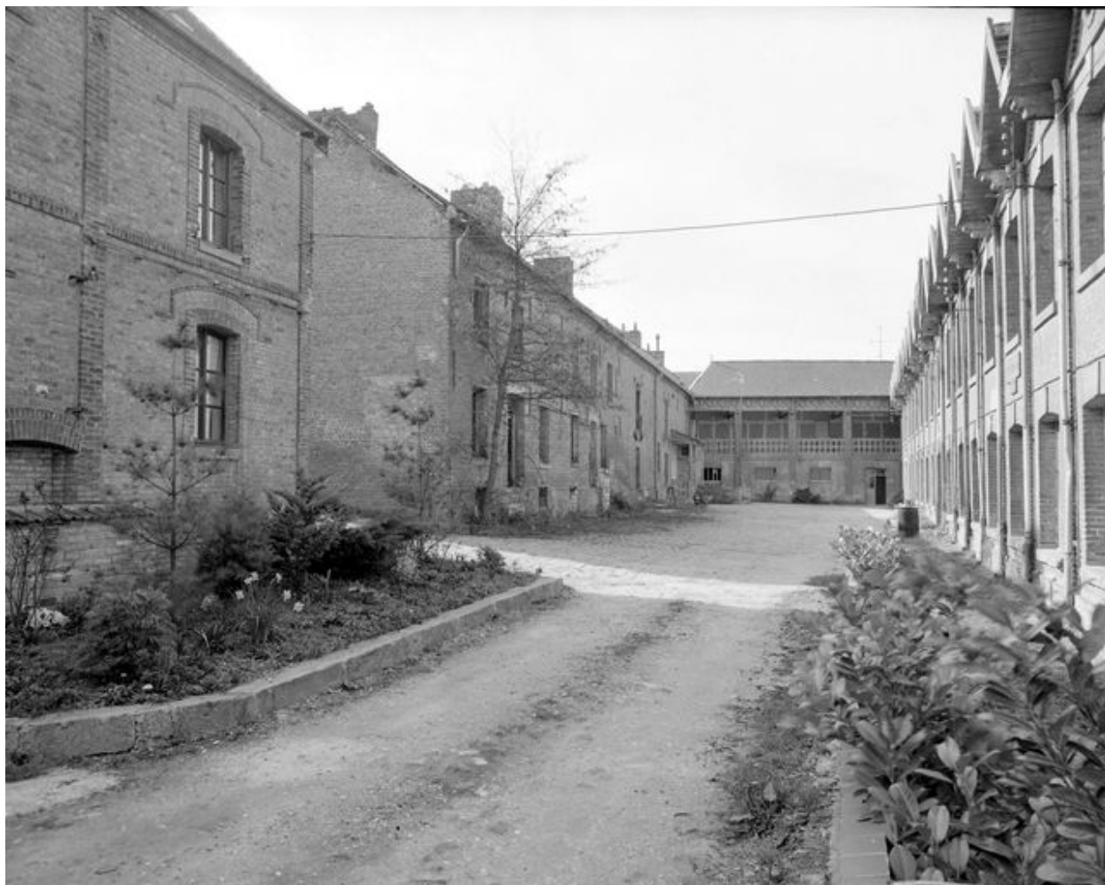
Cour, logements ouvriers et ateliers de fabrication.
