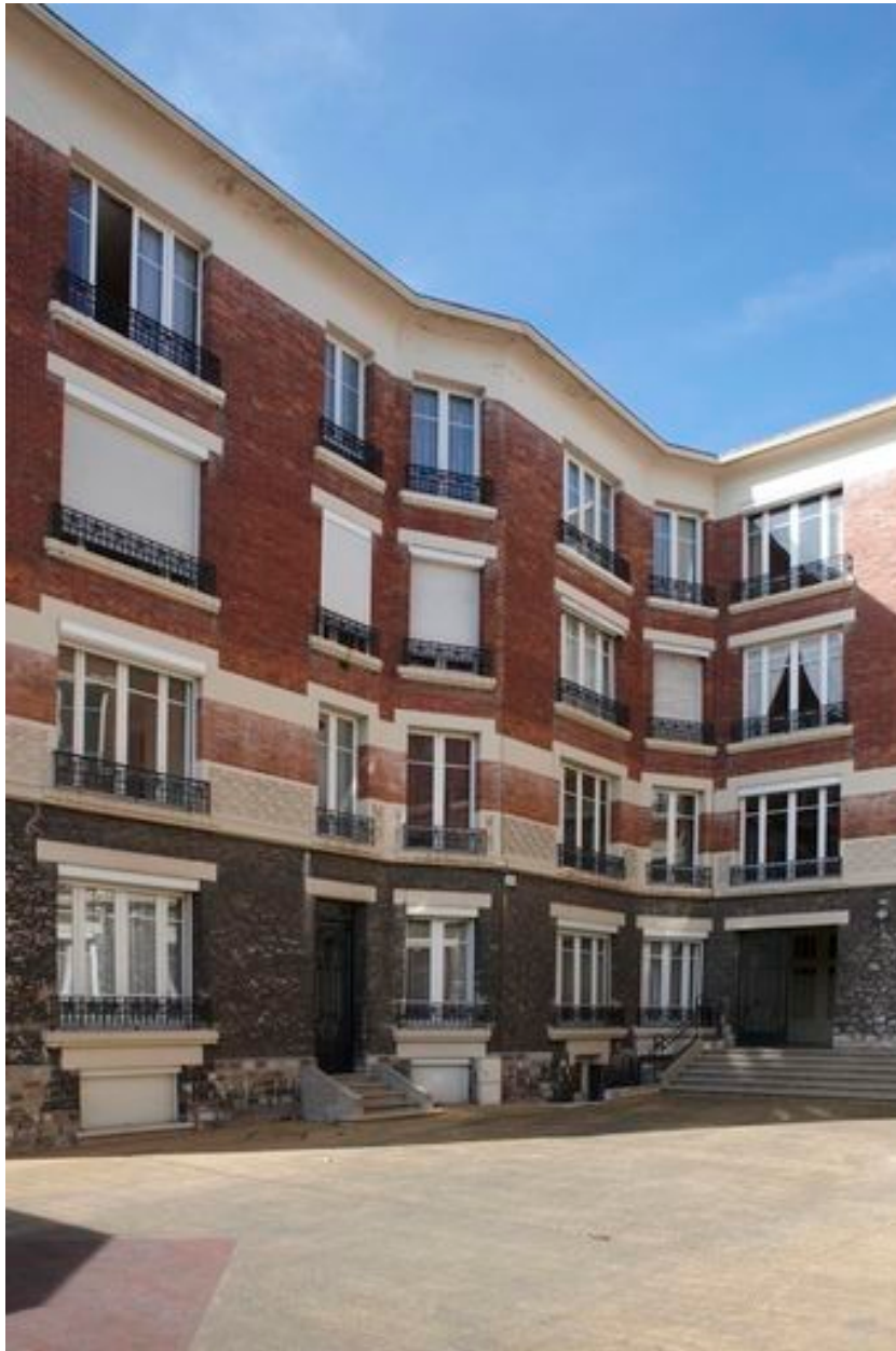
Partie latérale gauche de l'immeuble, à pans coupés.
