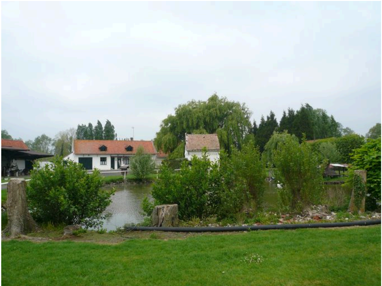
Vue générale depuis l'intérieur de la cour.
