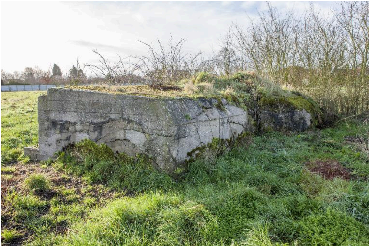
Casemate A : Vue générale vers le sud
