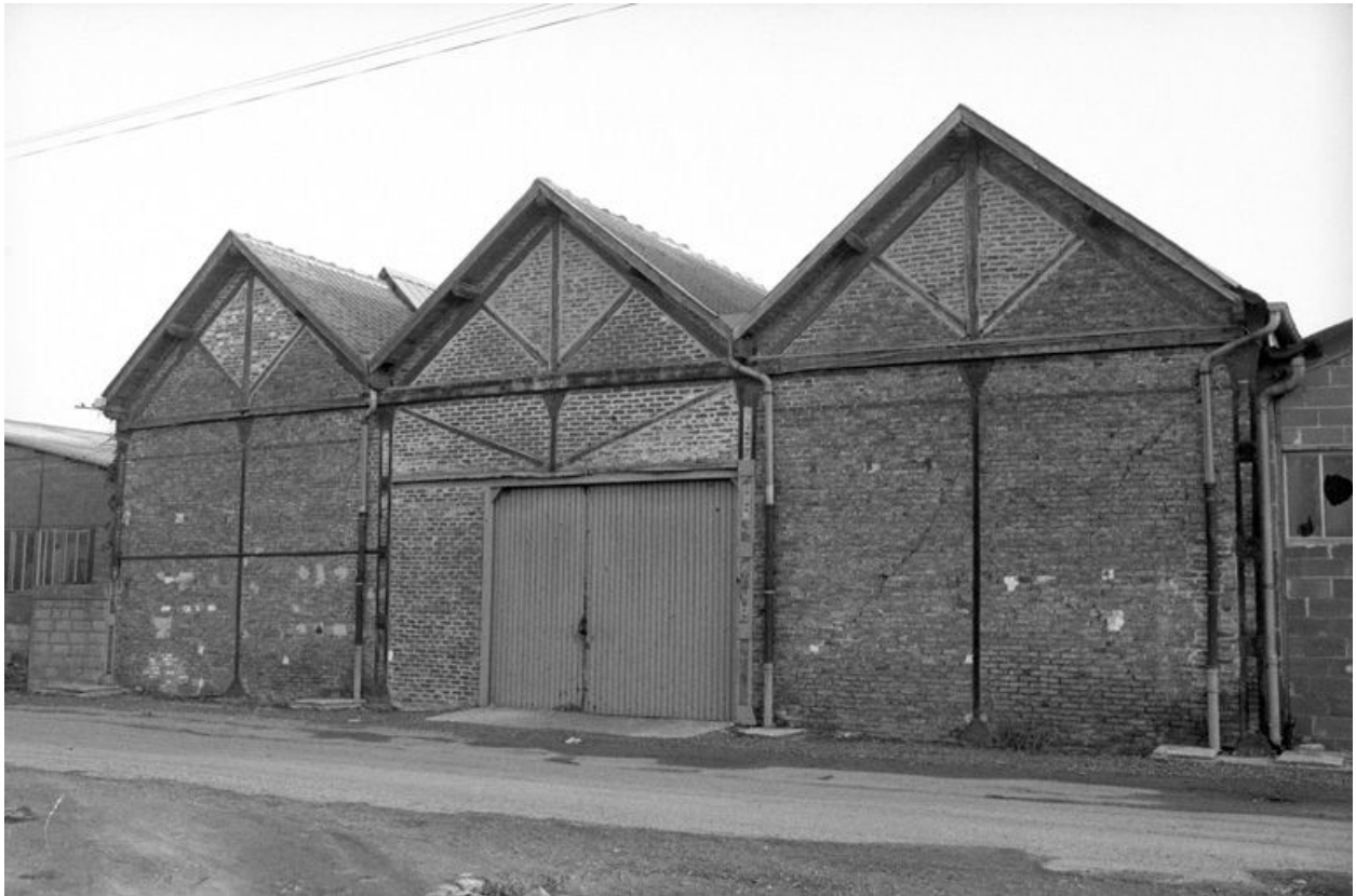
Entrepôt industriel sud, flanc ouest.
