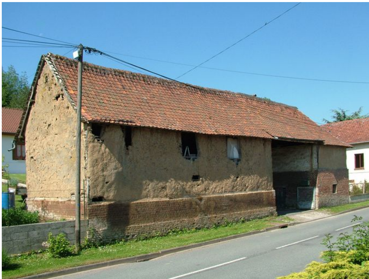
Grange de l'ancienne ferme, 13 rue Principale, 2e moitié du 19e siècle.
