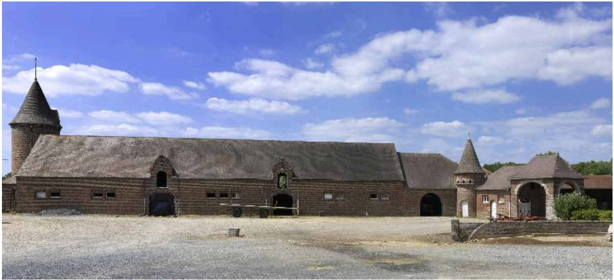
Façade sur cour des granges et du le pigeonnier.
