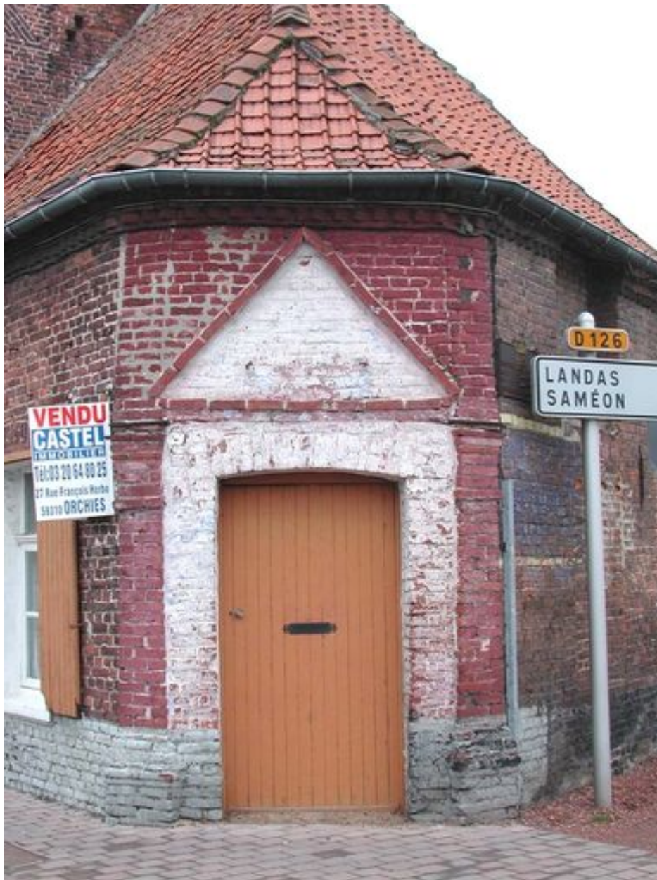
Détail de la travée d'angle.
