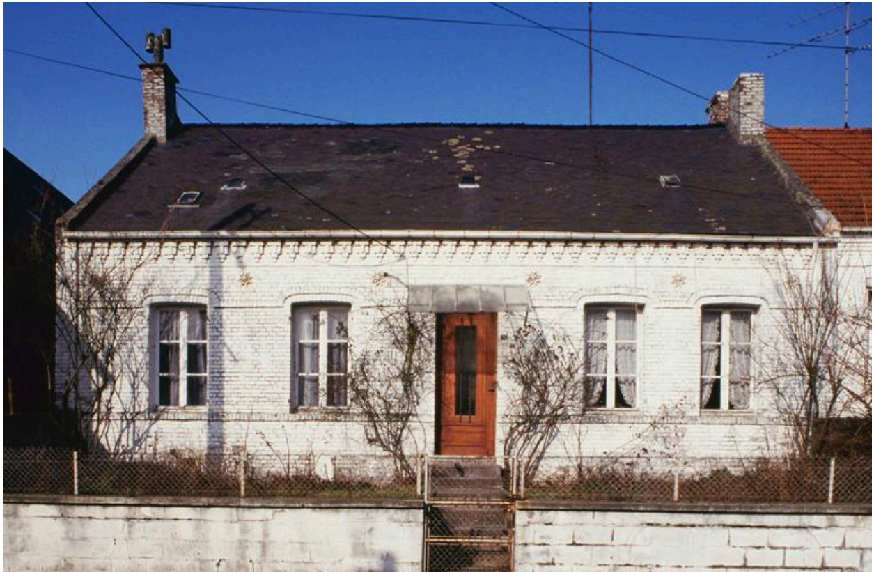
Vue d'ensemble de la façade.
