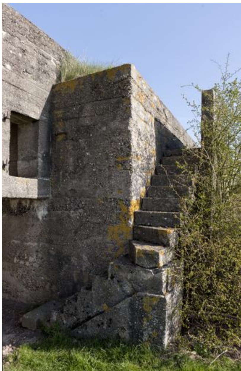
Accès à l'observatoire bétonnée (à gauche) et escalier menant à la tranchée surélevée.
