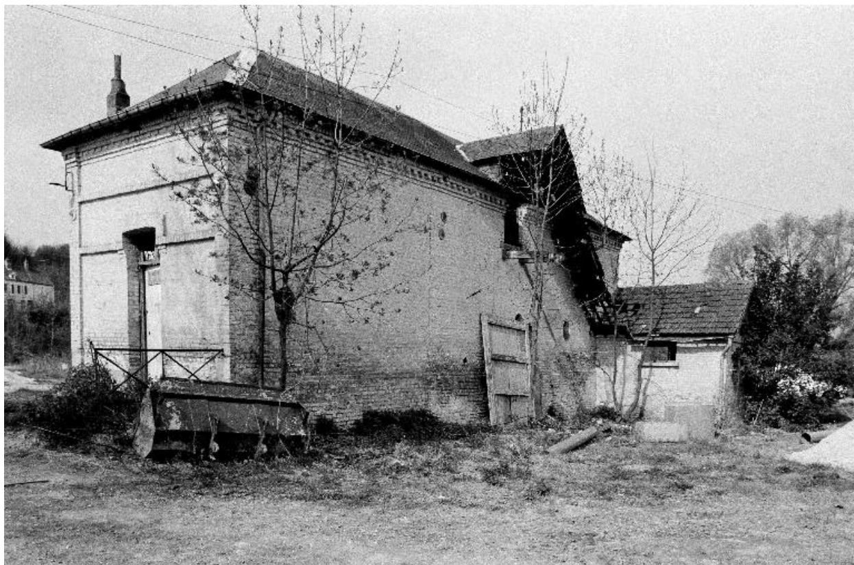
Conciergerie, élévation postérieure.
