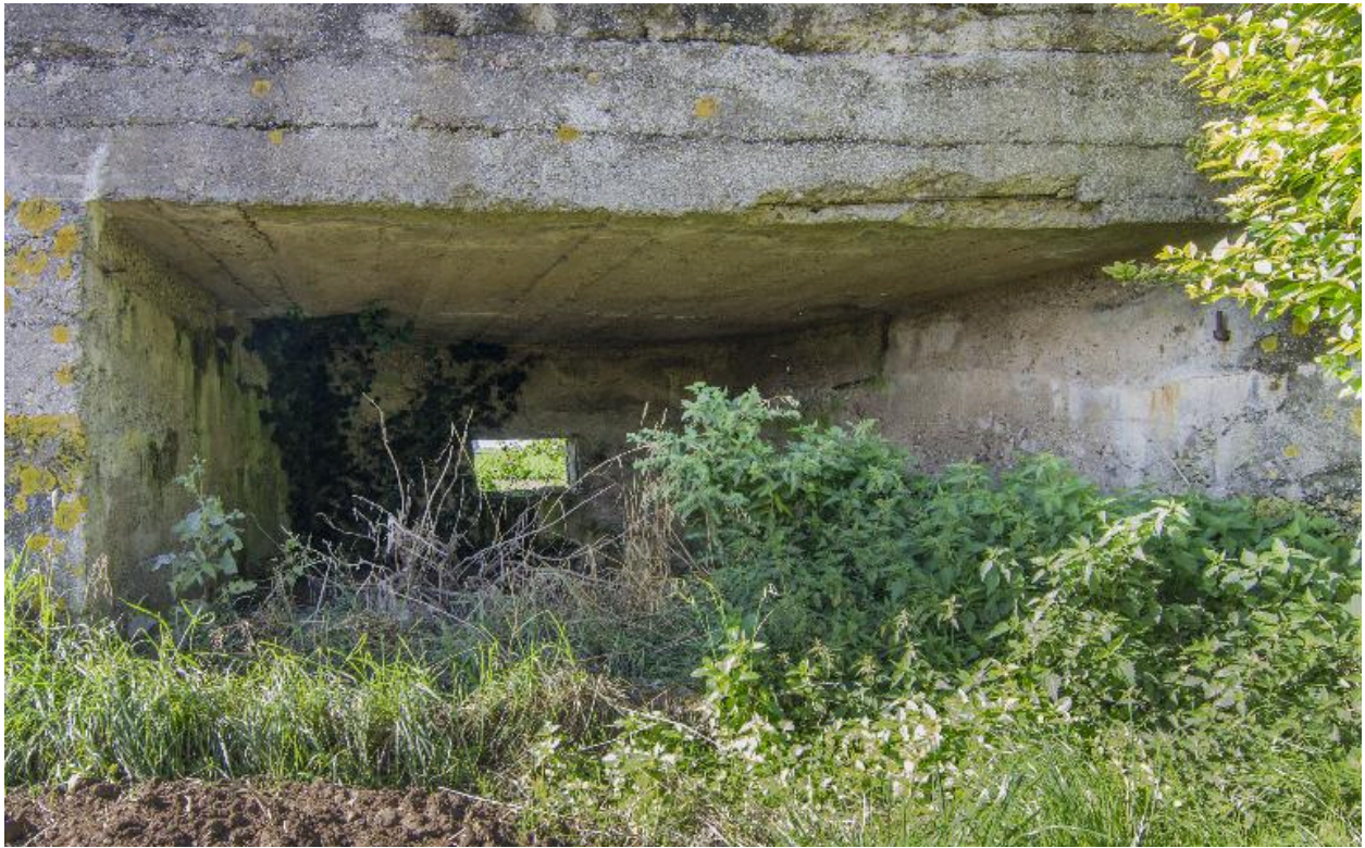
Chambre de tir, vers le nord-ouest
