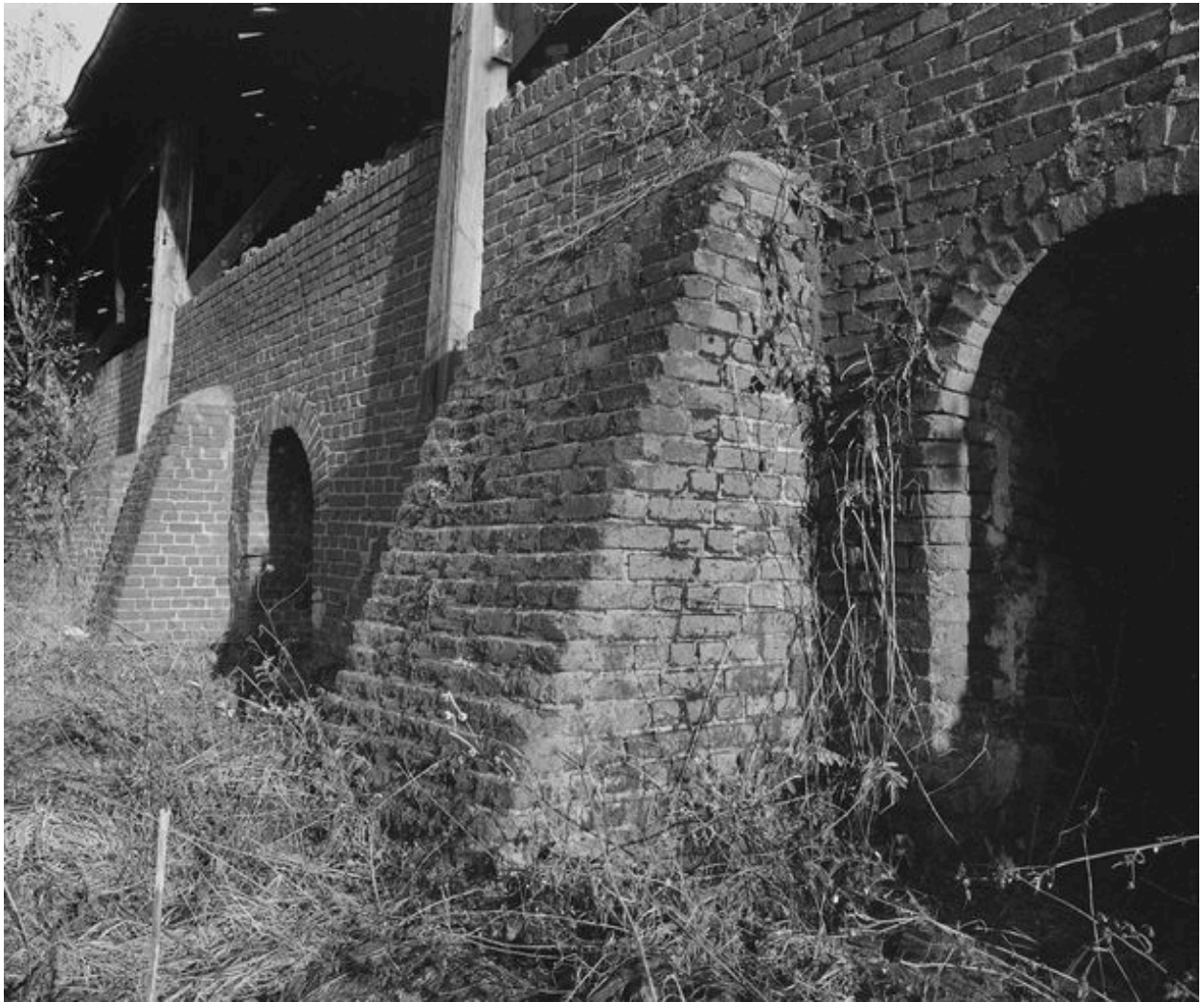
Façade ouest du four industriel avec contreforts en briques.
