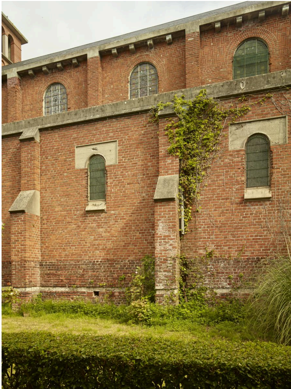
Vue de deux travées de la nef, côté sud.
