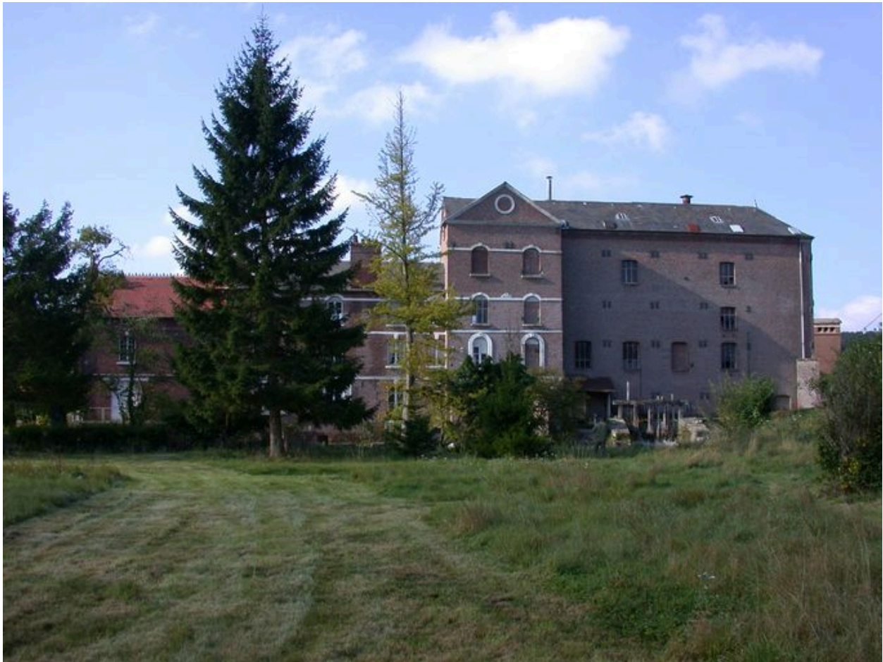
vue d'ensemble du bâtiment de la minoterie, façade postérieure.
