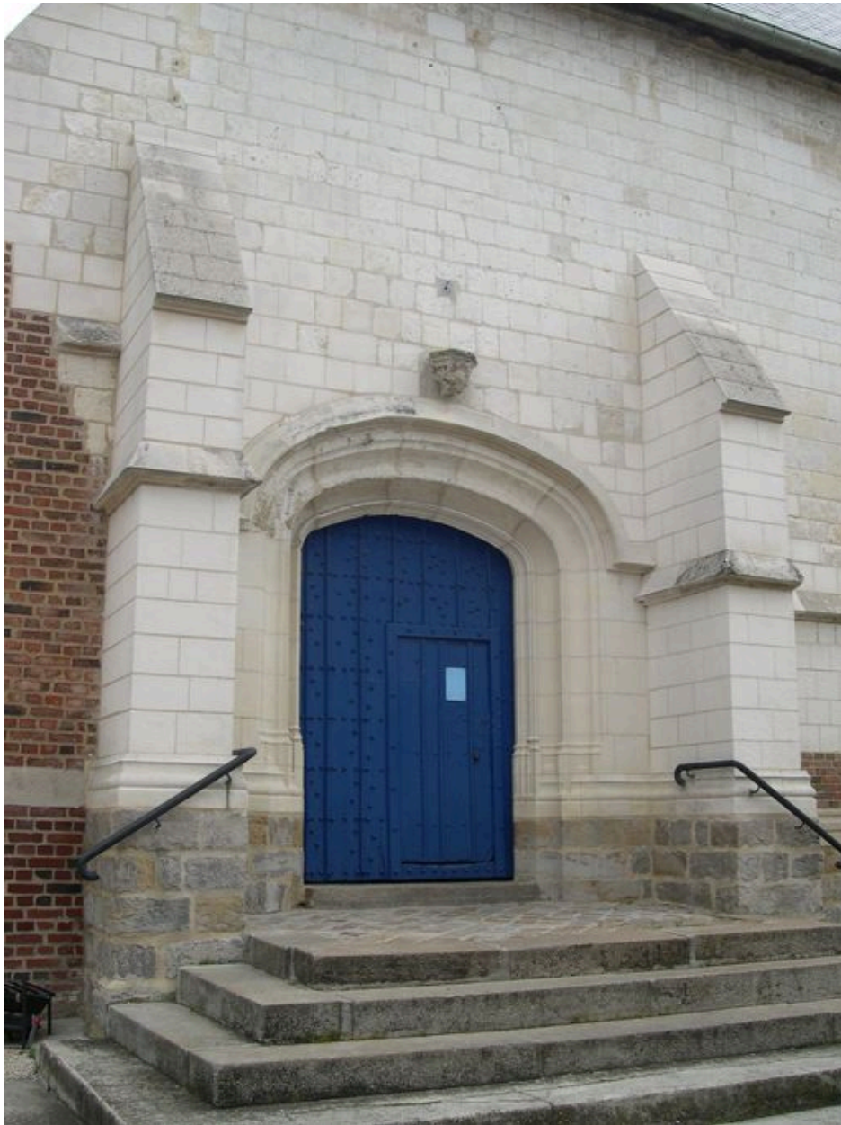
Vue de la façade sud : le portail.
