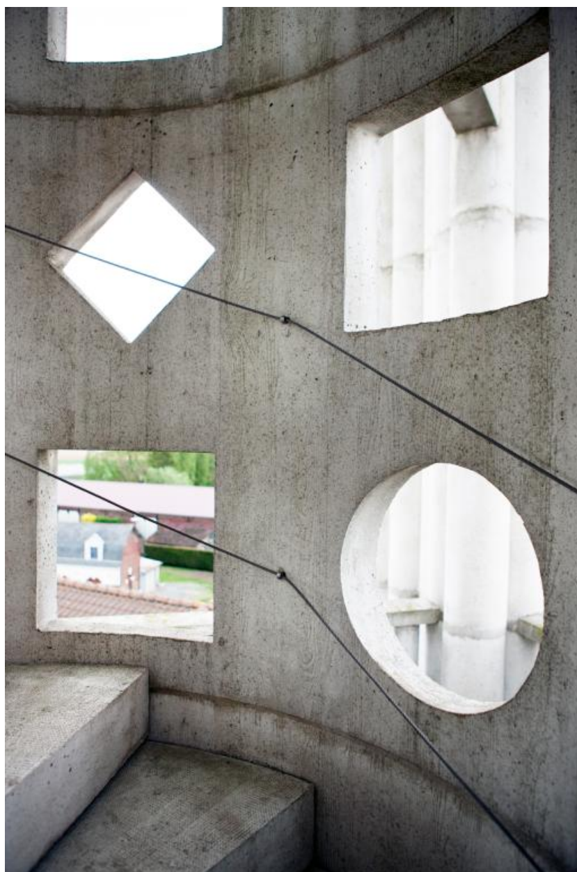
Vue intérieure de la tourelle d'escalier du campanile.
