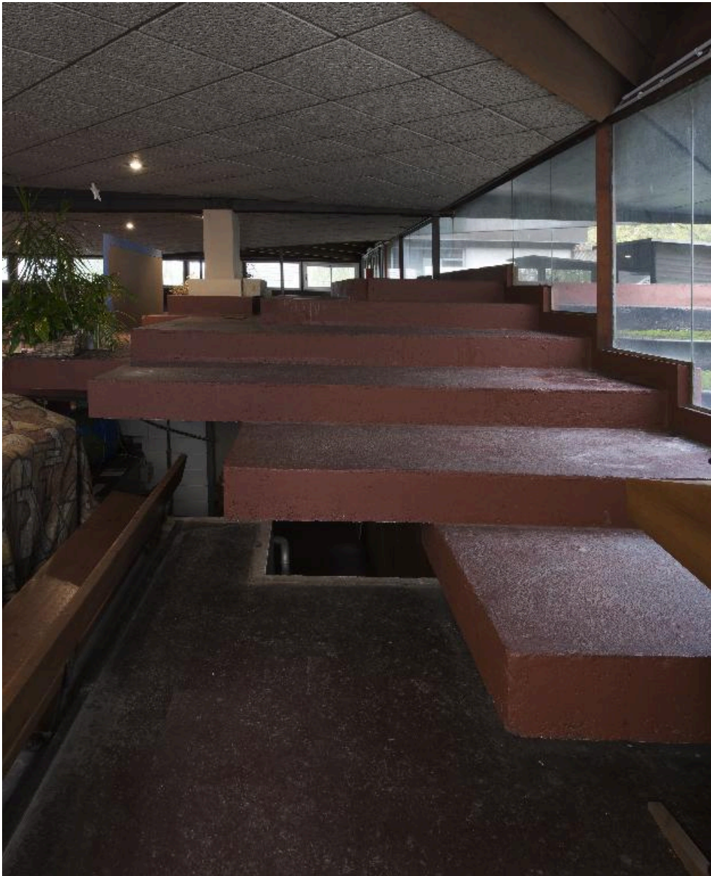
Vue de la dalle de couverture à gradins en suspens.
