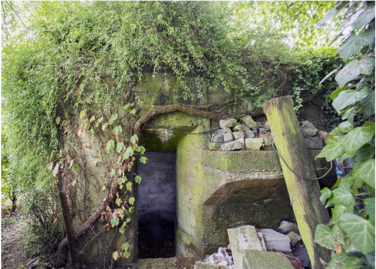
Elévation postérieure ou tournant le dos au front avec la banquette d'infanterie qui règne le long de la partie gauche de cette élévation, vue de détail de cette banquette avec, sur sa gauche, l'une des entrées de la casemate.
