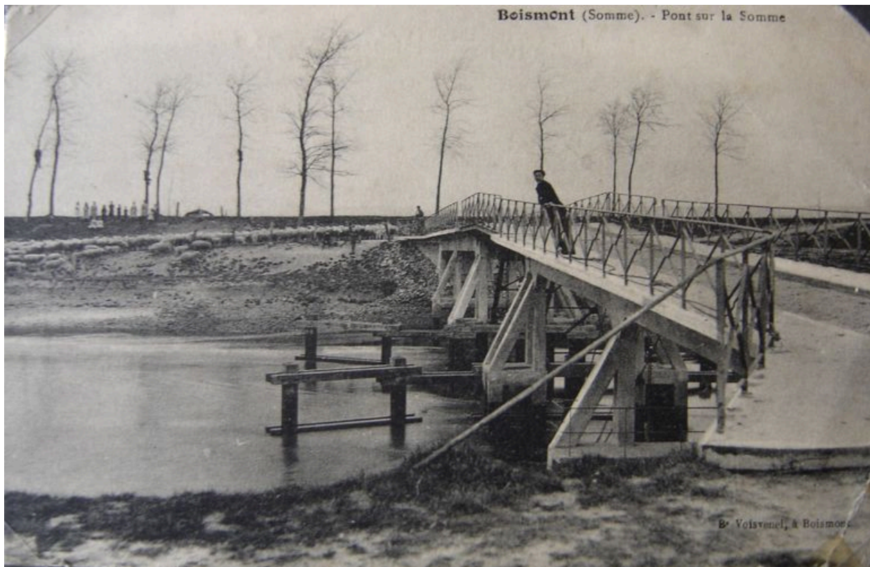
Vue du pont au début du 20e siècle située en face de la ferme.
