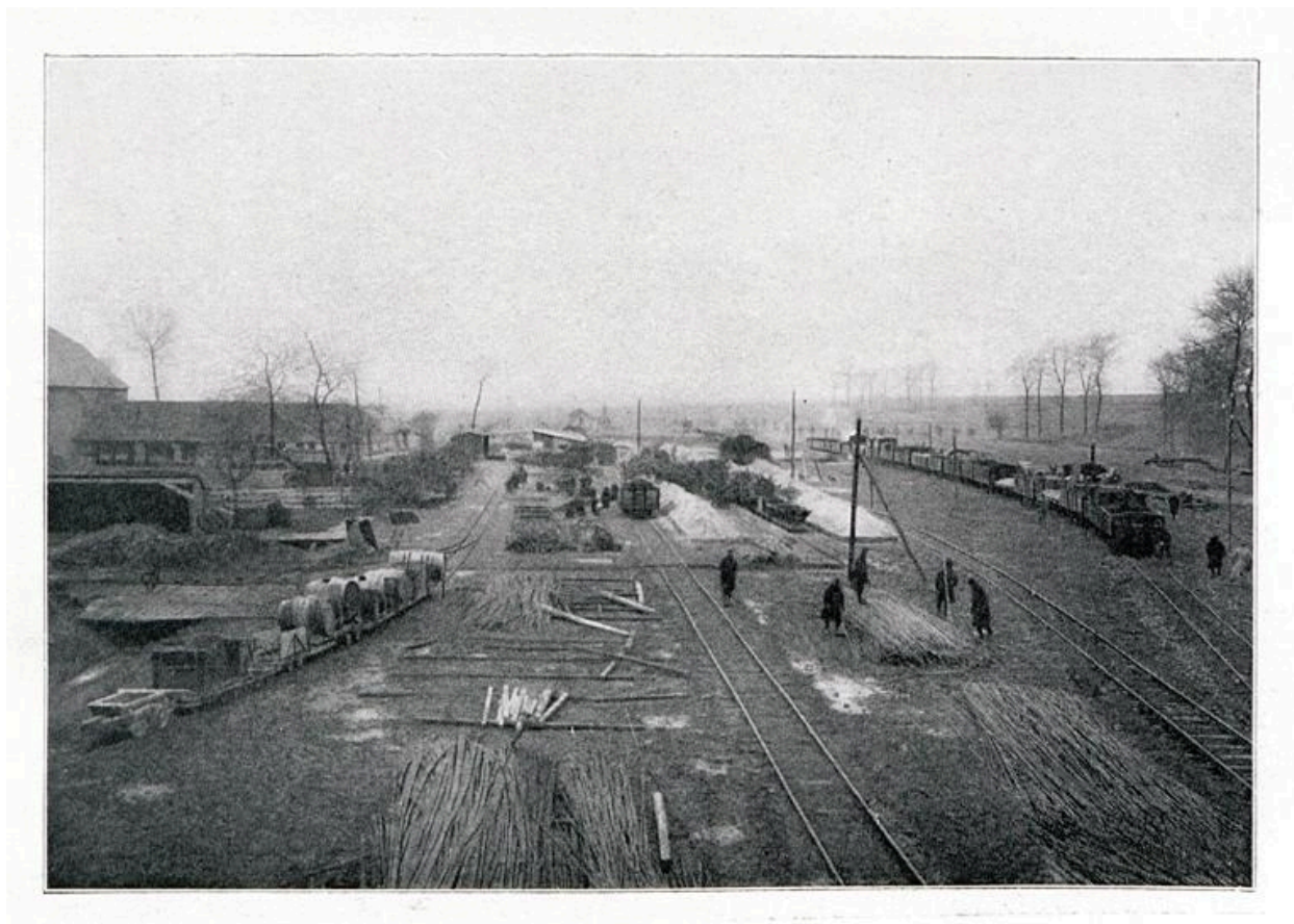
Parc à matériaux de Fontaine-lez-Croisilles (62). Fers à béton. in: Deutsche Frontbauarbeit im Kriege, p.128
