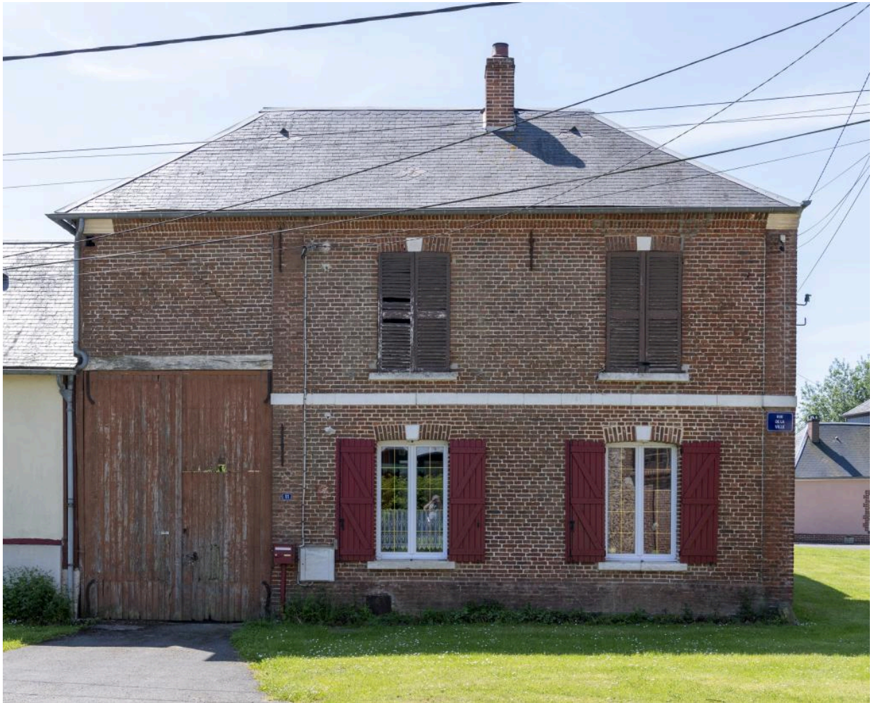
Logis sur rue avec entrée charretière, n°11 rue de la Ville, vue depuis le nord.
