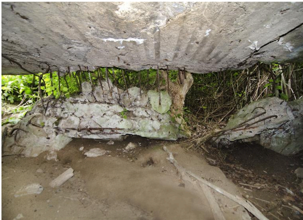
Le mur sud, explosé, de l'intérieur
