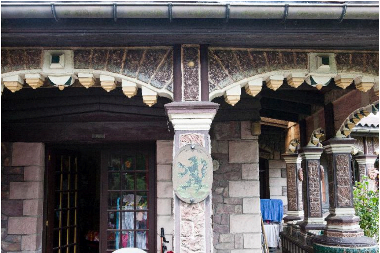
Terrasse, détail des arcades.
