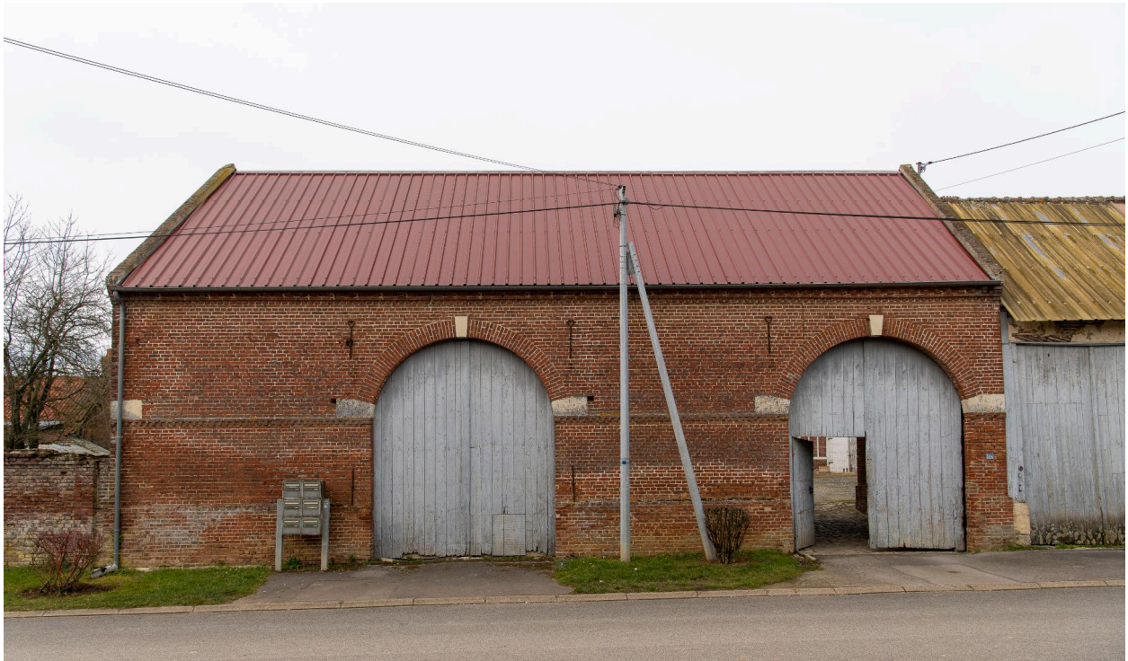
Grange sur rue, n°384 rue des Marronniers, vue depuis l'est.
