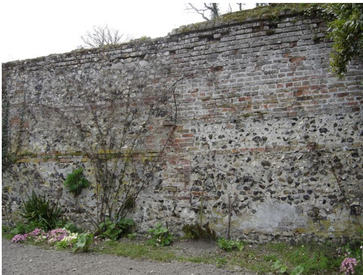
Détail du mur de clôture.
