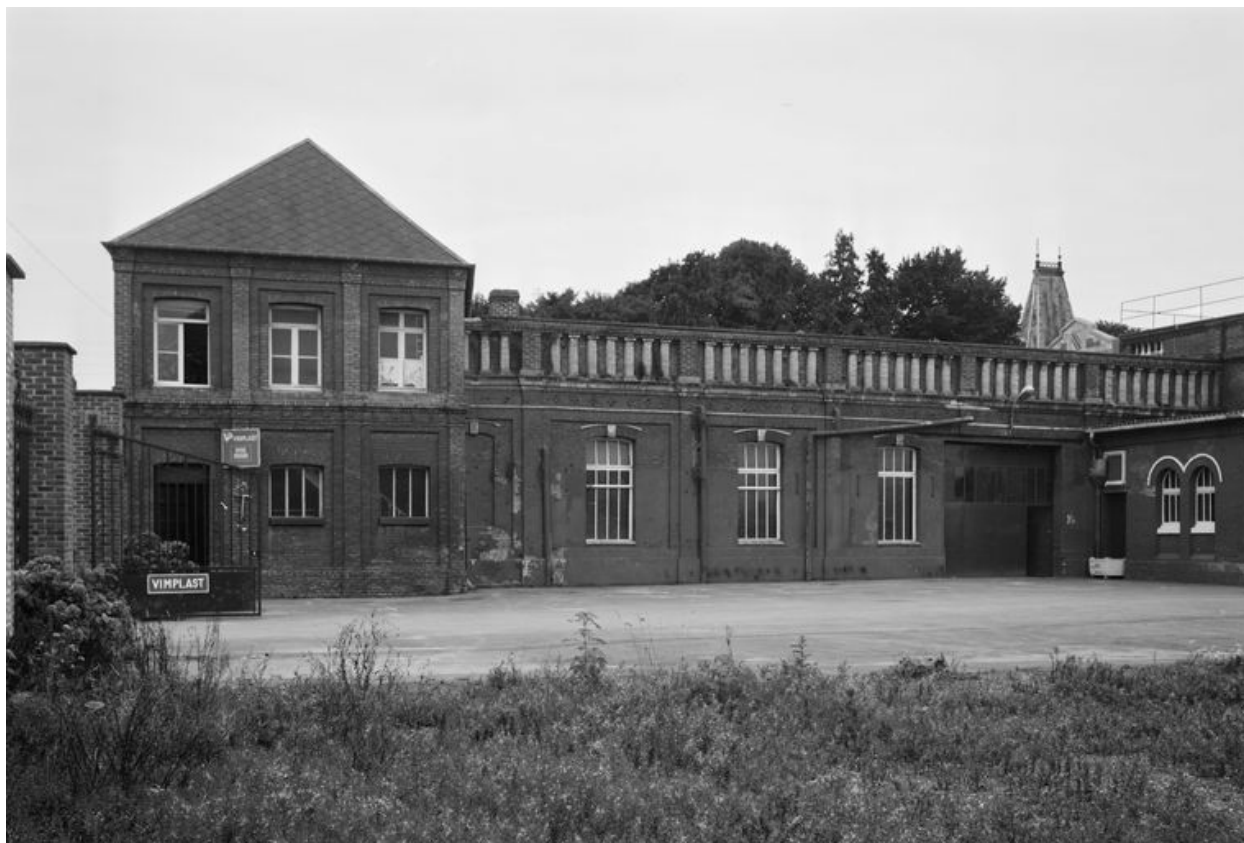
Atelier de fabrication et bureau, flanc est.
