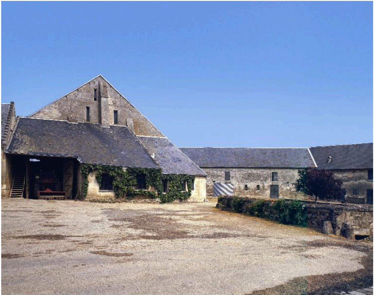
Vue des étables nord et du pignon sud-est de la grange.
