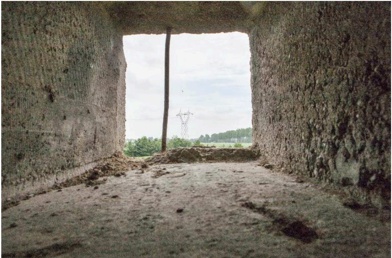
Premier étage, créneau de fusillade vers l'est
