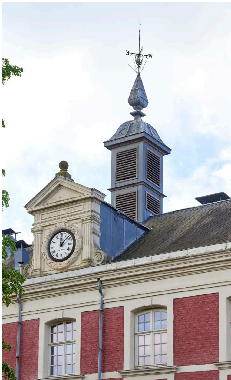
Détail de la lucarne à fronton triangulaire couronnant la travée centrale de l'aile de l'Horloge sur la cour d'honneur.
