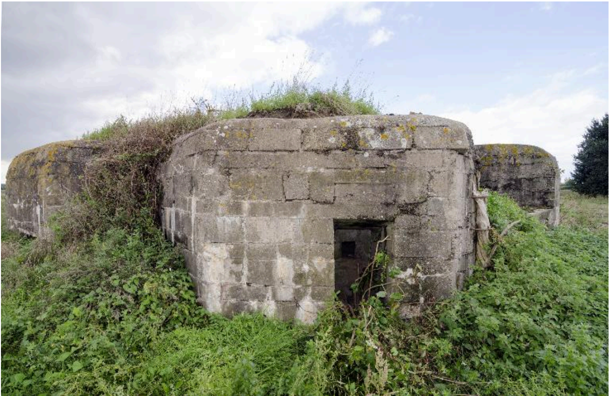
Vue de trois-quarts, vers nord-ouest. Entrée sud-est
