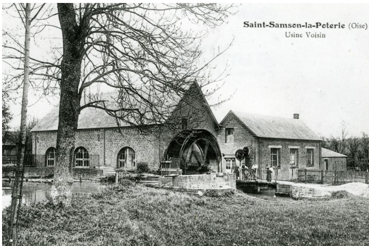
Vue du moulin, usine de frottage de verre, vers 1905 (carte postale, coll. part.)
