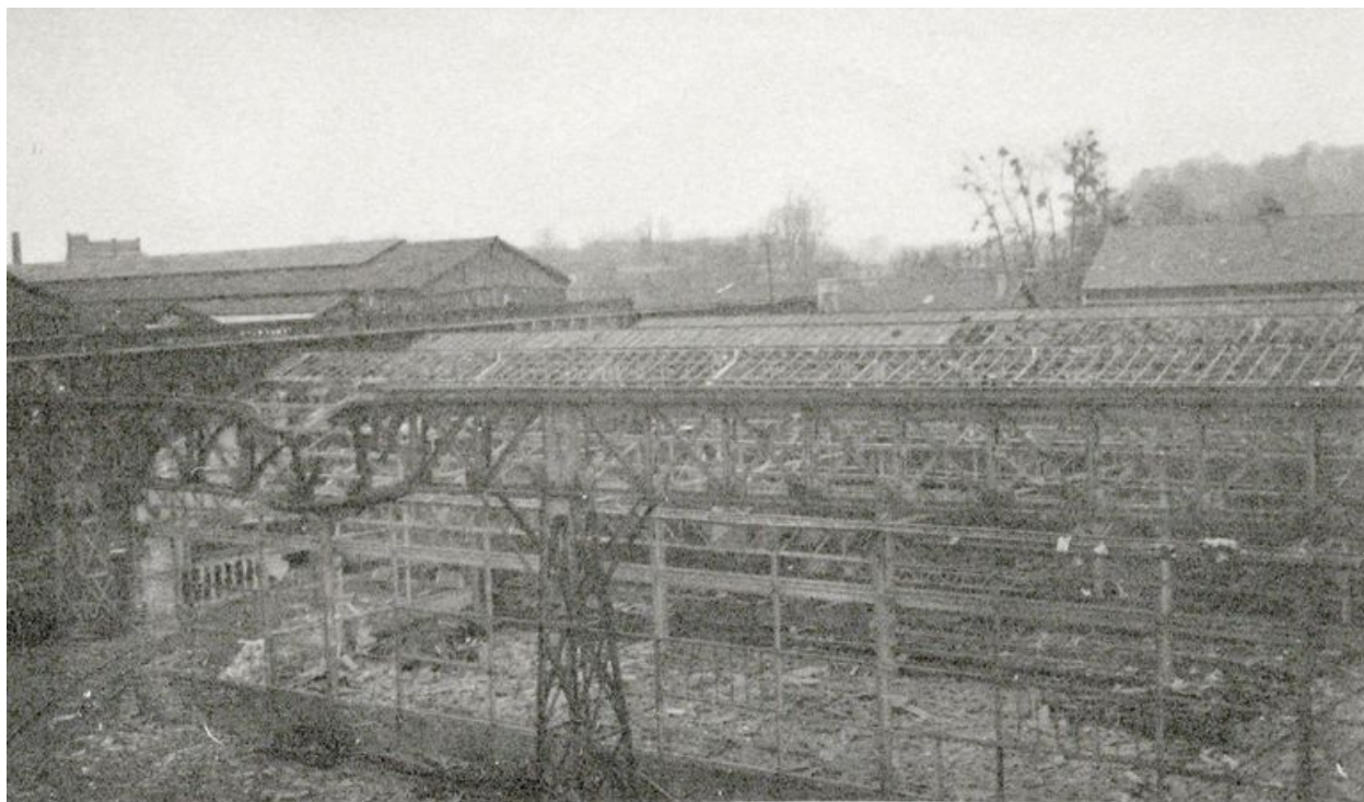
Bombardement du chemin de roulement du pont-roulant, 1944 (AD Oise ; 617W18128).
