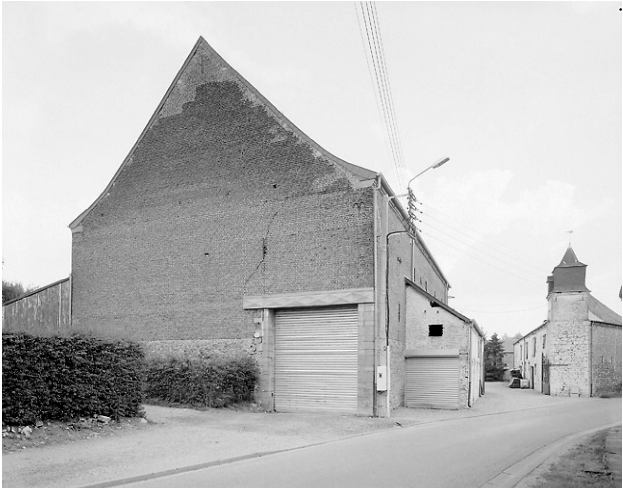
Vue de la grange depuis la rue de l'Hôpital.
