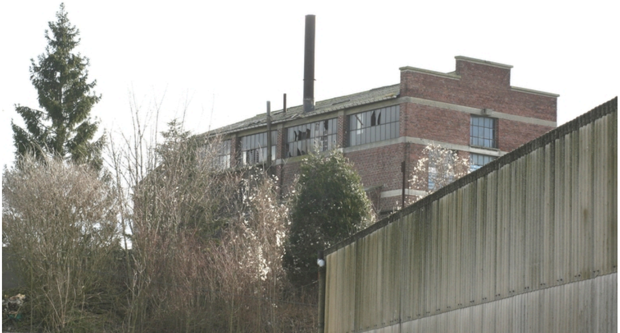
La centrale thermique, vue depuis les entrepôts.
