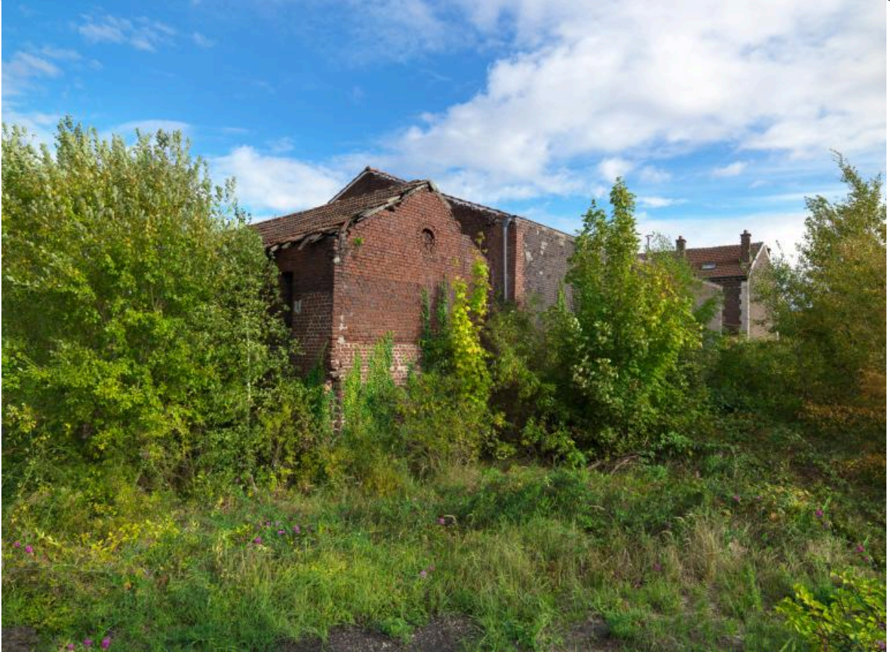
Ancienne scierie Delaplace : vue du hangar de la machine à vapeur et du bâtiment de quatre logements devenus salle de répétition depuis le nord-est du site
